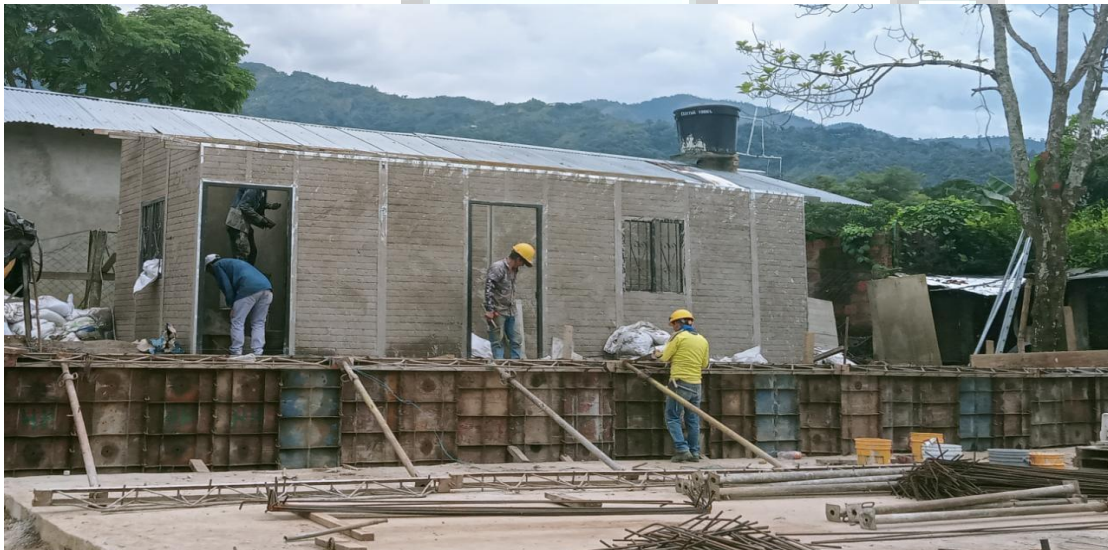
Ilustración 9 NP.24.1 Caseta prefabricada terminada en obra blanca, con instalaciones hidráulicas, sanitarias y eléctricas, incluye aparatos sanitarios
