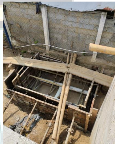
Ilustración 8 NP.9 Suministro e instalación de cajas en concreto 2 X 2,50 de 3000 PSI para BYPASS
