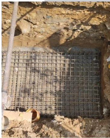
Ilustración 8 NP.9 Suministro e instalación de cajas en concreto 2 X 2,50 de 3000 PSI para BYPASS
